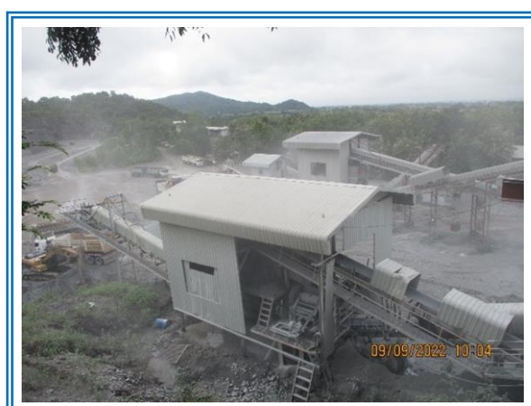
รูปที่ 3-12 อาคารโรงม่หินแบบปิดคลุม
